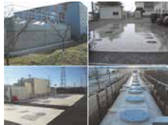
高濃度油分含有排水処理技術
