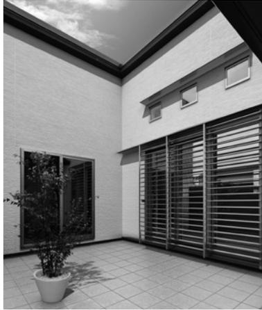
**評価** 開口部の外で日射熱を遮熱することで室内温度の上昇を抑え、エアコンなど空調設備への依存を少なくし、快適な住環境を実現する上吊り引き戸形式のルーバーである。ルーバー障子の開閉により、夏の風通しや冬の日射を有効に利用でき、すだれや内部ブラインド等と比較して室内が薄暗くならず圧迫感もなく、快適な部屋を保つことができる。主材料は製造時に発生するアルミニウム端材等をリサイクルするなど、省エネ・省資源と利便性の両立を実現している。自然の風や太陽を利用し地球温暖化の防止に寄与する優れたエコプロダクツである。
