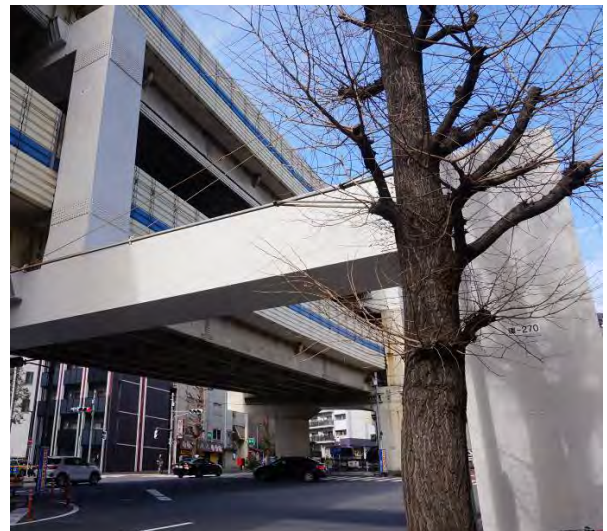
水性塗料施工後(橋脚部、全景)
