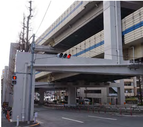
水性塗料施工後(橋脚部、全景)
