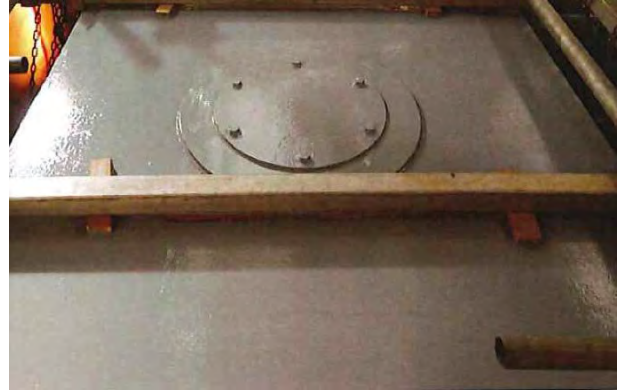
水性塗料塗布後(足場内)
