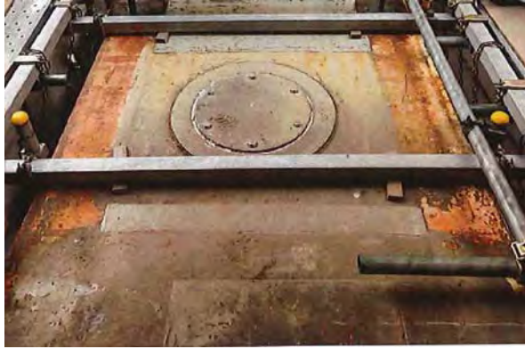
塗装前状況(足場内)
